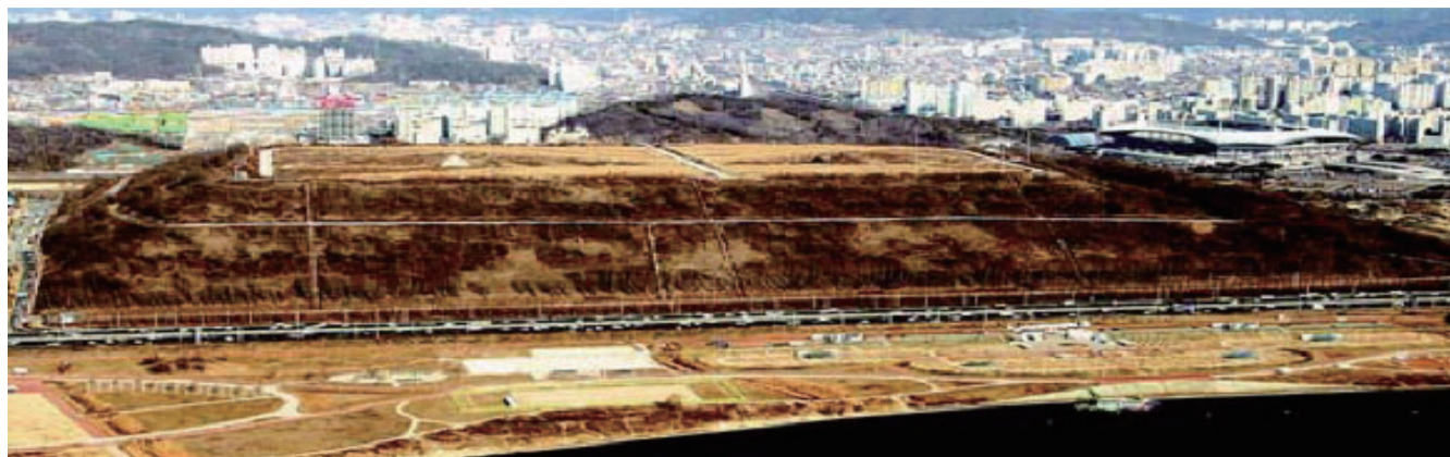
La décharge désaffectée de Nanjido 1 durant le processus de reconversion en Parc Haneul. On notera l'épaisseur de déchets déposés dans la décharge en comparant avec la hauteur des bâtiments du premier plan.
