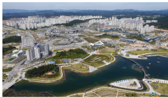
세종특별자치시 건설 모습
