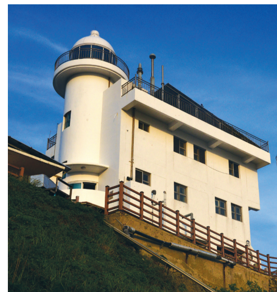
독도 등대 1954년 8월 최초 설치/1968년 12월 중축 및 유인화(3명 근무)/등탑 높이 15m, 넓이 161㎡/광원 거리 25마일/다열 발전기 27(75kW)/태양 광 발전(15kW)
