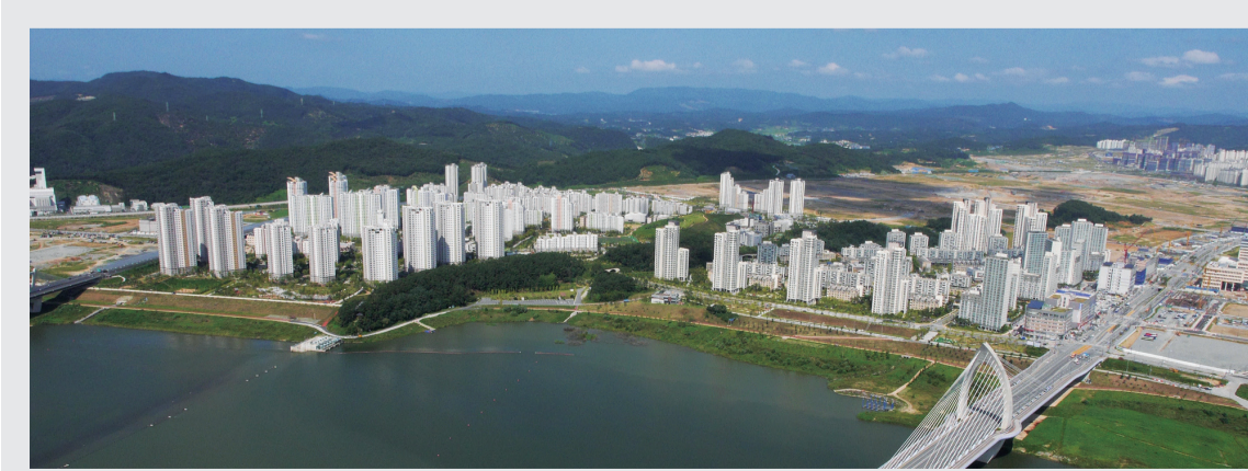
세종특별자치시 건설 모습
