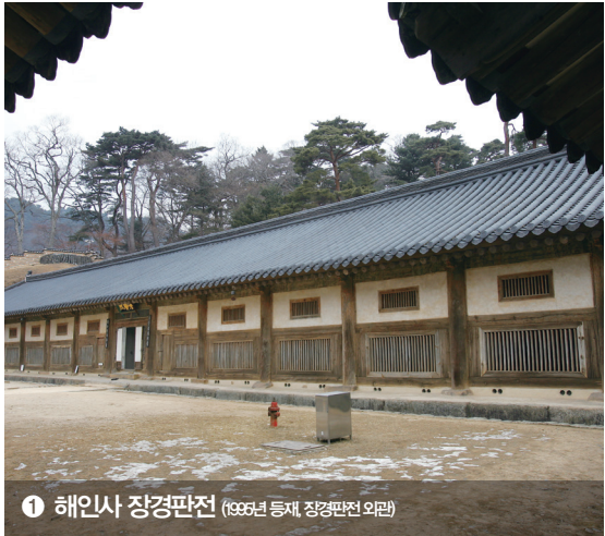
1 해인사 장경판전 (1995년 등재, 장경판전 외관) 경상남도 함천군 해인사 장경판전은 13세기에 만들어진 세계적 문화유산인 고려 대장경판 8만여 장을 보존하는 보고로서, 해인사의 현존 건물 중 가장 오래된 건물이다. 원형의 통풍과 방습, 실내 적정 온도 유지, 판가의 진열 장치 등이 매우 과학적이며 합리적으로 되어 있어 고려대장경판이 지금까지 온전하게 보존되고 있다.
