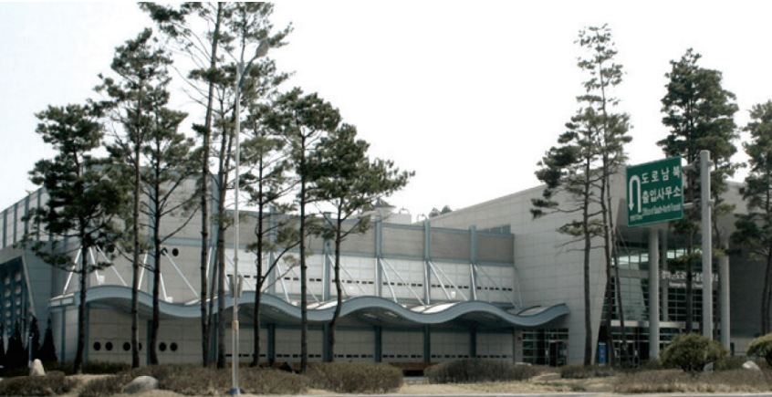
경의선 도로 출입 시설
