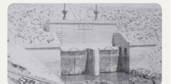
명지 수문 준공(김해군 명지면) - 폭 1.85m 높이 1.25m, 길이 24.5m - 공사비 12,000엔 - 착수 1935.11.1. 준공 1936.3.3.
