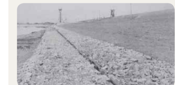
초정 호안 공사(김해군 하천면 초정리, 대저면 출두리) - 사석 연장 775m - 공사비 2,000엔 - 착수 1935.10.16. 준공 1935.12.4.
