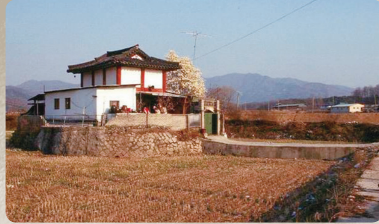
터돌움집(경기도 포천시) 강수량이 많거나 큰 하천 주변의 지대가 낮은 곳은 침수 피해를 자주 입는다. 이를 피하기 위해 가옥을 지을 때 터를 높여서 집을 짓는다.
