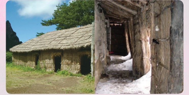
우데기와 축담(경상북도 울릉군) 우데기는 처마 끝에 억새 등을 엮어 눈이나 비가 안쪽으로 침투하지 못하도록 만든 집이다. 우데기와 가옥의 벽 사이의 공간인 축담은 이동 통로로 사용된다. 해안가 가옥의 우데기는 바람을 막는 역할도 하였다.
