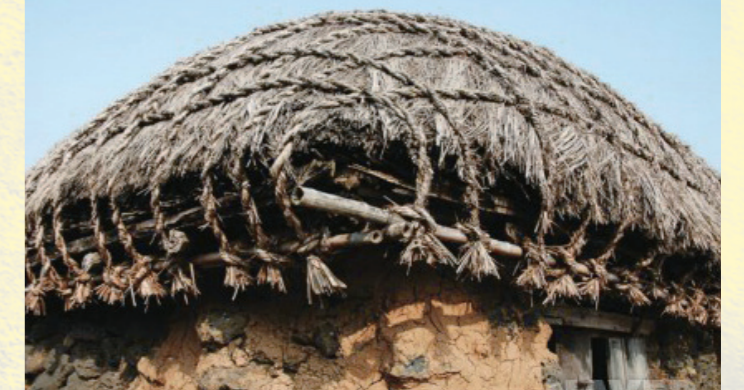
제주도 전통 가옥(제주특별자치도 서귀포시) 제주도 가옥의 지붕 경사는 완만하다. 이는 제주도가 우리나라에서 강수량이 가장 많은 지방이지만 바람이 강하기 때문이다. 제주도의 지붕은 새(茅)를 덮고 다시 새를 꼬아서 만든 줄로 지붕을 단단하게 엮었다.
